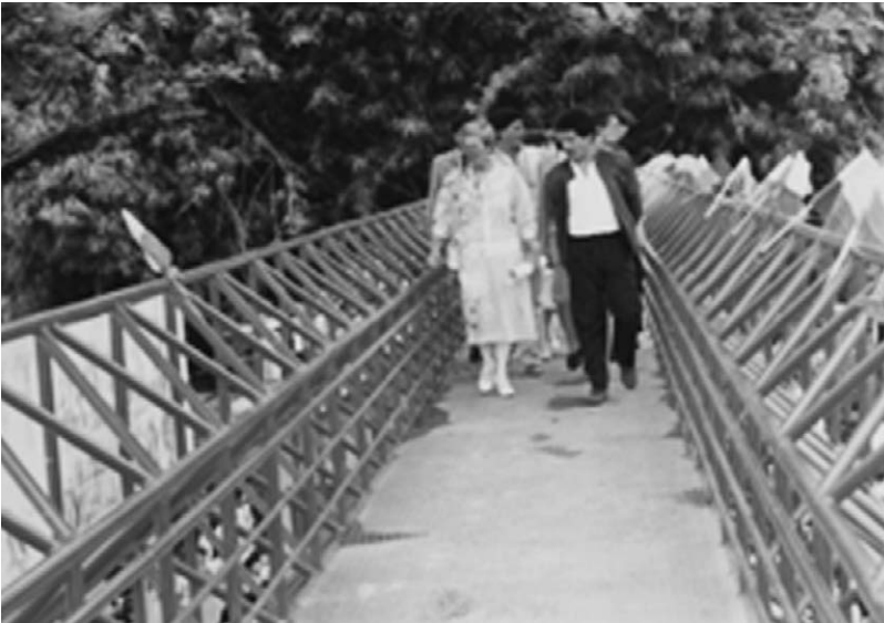
Inauguración del puente peatonal de la carrera Quinta con calle 30
