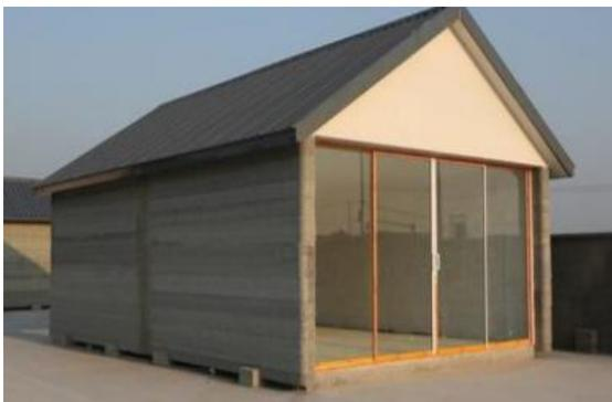
**Ilustración 8.** Vivienda construida mediante impresión 3D
