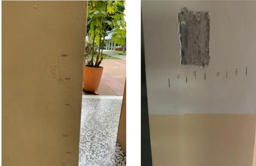
Se definió entonces, un recubrimiento que se encuentra entre los 4 y los 5 cm debido a la cantidad de columnas de tipos distintos.
