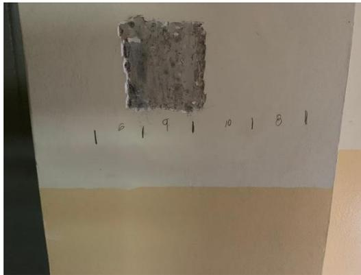
Con los datos obtenidos se realizó un detalle aproximado de la disposición del acero de refuerzo transversal para realizar la verificación y así como el chequeo de las separaciones máximas establecidas por el NSR-10 para capacidad de disipación de energía moderada DMO y especial DES.
